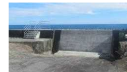
コンクリートによる陸こうの閉鎖
