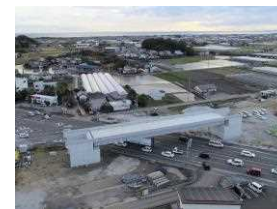
高知東部自動車道 南国安芸道路(香南市)
