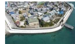
海岸堤防の耐震対策
