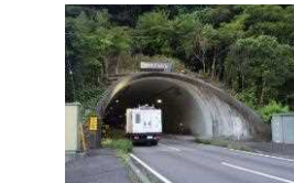
国道441号 網代トンネルの点検状況
