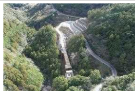
国道494号佐川～吾桑BPの整備
