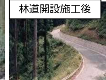
林道開設施工後
