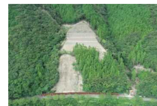
【浦越(四万十町) 復旧治山工事】
