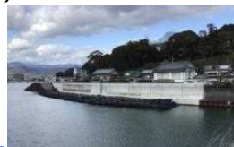
海岸堤防の耐震対策
