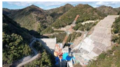
和食ダム建設
