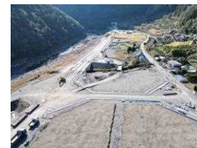
国道493号 (北川道路2-2工区)
