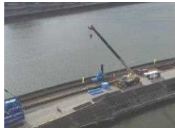
【国分川】 (河川堤防の耐震対策)
