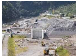
【国道493号】 (北川道路の整備)
