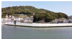
【高知港海岸】 (海岸堤防の地震・津波対策)
