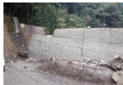
【瀬戸ヶ谷川】 (砂防堰堤の整備)
