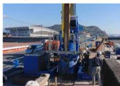
河川堤防の耐震対策
