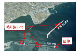
高知港防波堤の整備
