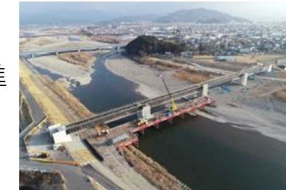
高知東部自動車道 南国安芸道路(香南市)
