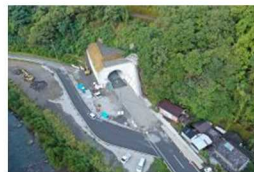
安田東洋線におけるトンネル整備
