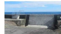
コンクリートによる陸こうの閉鎖
