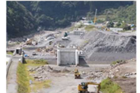
国道493号 (北川道路2-2工区)
