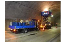
歯染ノ浦トンネルの補修状況
