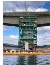
須崎仁ノ線 仁淀川河口大橋
