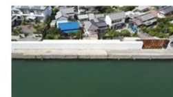
海岸堤防の耐震補強状況
