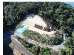
安満地福良線における線形改良
