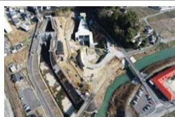
日下川（放水路整備）
