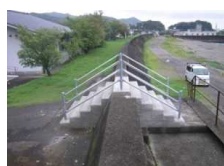
コンクリートによる陸こうの閉鎖
