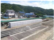
海岸堤防の耐震補強状況
