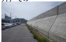
海岸堤防の耐震補強状況
