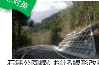
石鎚公園線における線形改良
