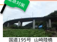
国道195号 山崎陸橋
