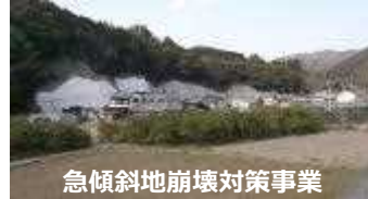
急傾斜地崩壊対策事業
