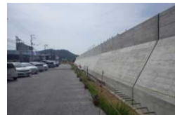
海岸堤防の耐震補強状況
