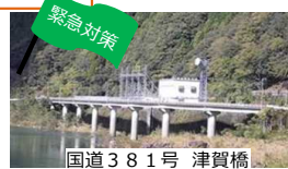
国道 381 号 津賀橋
