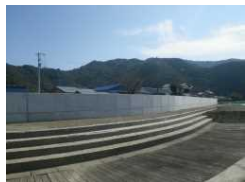
海岸堤防の耐震補強状況
