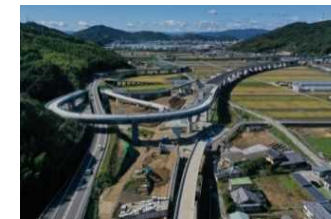
E55 高知東部自動車道 高知南国道路 (高知市)
