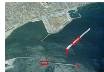
高知港防波堤の整備
