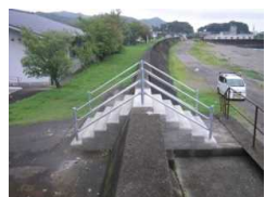
コンクリートによる陸こうの閉鎖
